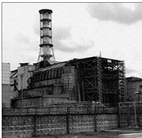
Fig.3 Blindaje de contención realizado por los “liquidadores”, popularmente conocido como “sarcófago”. Actualmente, con ayuda internacional, se ha construido uno nuevo debido a las fugas y fallos estructurales detectados en el antiguo.
